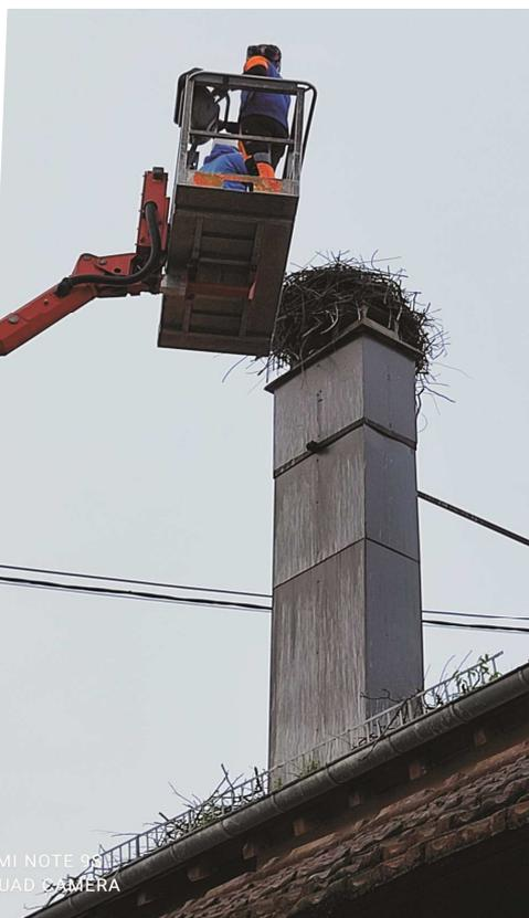
En effet, ces nids empêchaient une évacuation normale des fumées des cheminées où ils étaient installés, causant de nombreux dysfonctionnements des chaudières et d'importantes dégradations de la charpente du toit de l'école de musique.
