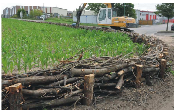
Fascines rue du Ried
